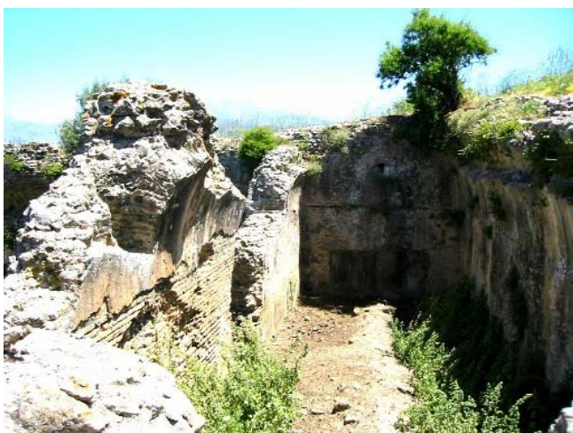
Die li. Abb. zeigt einen Gebäudetrakt, an dessen Mauerresten (links und rechts, im oberen Drittel) Ansätze eines "venezianischen Bogens" erkennbar sind; Reste von "venezianischem Spachtelputz" sind hier ebenfalls in Fragmenten, teils mit Farbresten, erhalten. Die bis zu 1 m dicken Mauerreste (Abb. re.) und die Raumanordnung deuten auf eine Bauart nach "venezianischer Militärarchitektur" hin.
