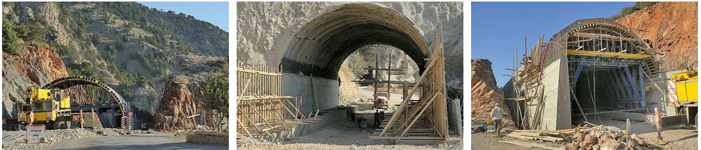
Im Juli und August 2008 wird der südliche, 3. Tunnel künstlich aufgebaut und in das Landschaftsbild integriert.
