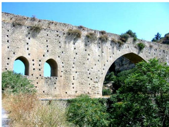
Das Aquädukt überspannt in zwei übereinander stehenden Bögen das Tal und den Bach, hier aus Sicht der Straße nach Spília (Abb. links). Die Abb. rechts zeigt die "Rückseite" vom Weg durch das Aquädukt. Die untere Mauerstärke liegt bei etwa 4 m, die obere bei rd. 2 m, wobei der obere Teil von beiden Seiten (mit entsprechender Vorsicht) begehbar ist. Die unzähligen Nischen dienen einer benachbarten Dohlenkolonie und Tauben als Unterschlupf und Bruthöhle.
